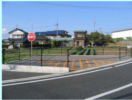
■ 整備された耐震性防火貯水槽
