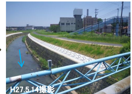
護岸嵩上状況
