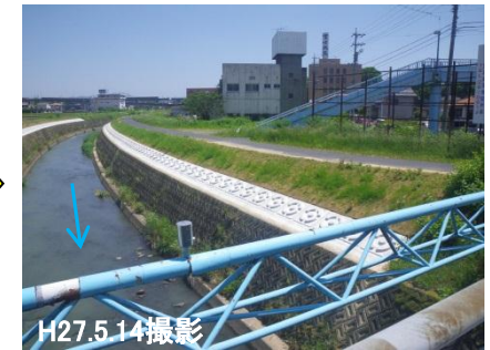
護岸嵩上状況
