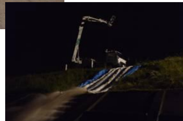
H23. 9台風15号における排水ポンプ車、照明車の作業状況
