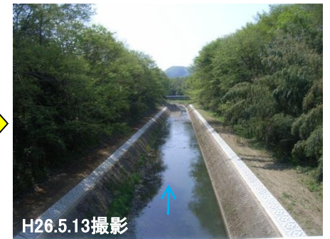
護岸嵩上状況
