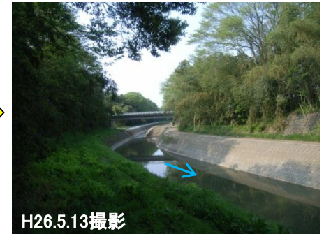
河道掘削状況
