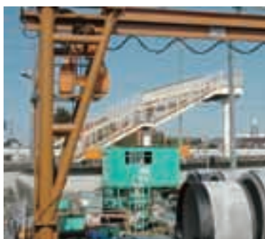
▲本郷雨水管渠築造工事(川合町)
