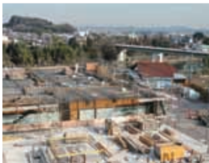
▲森山浄水場改築工事(森山町)
