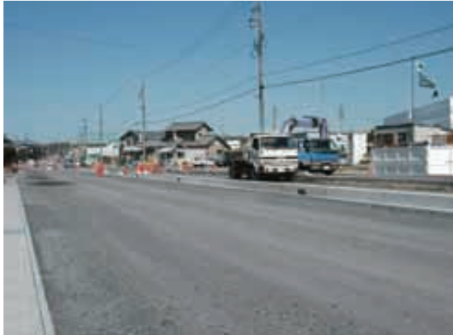
◀急ピッチで工事が進む西畑正理線(3月撮影)
