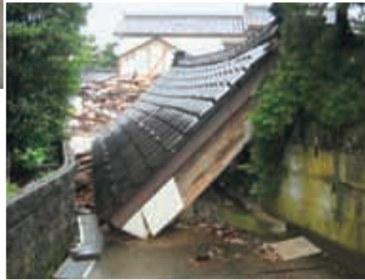
被災した家屋（新潟県中越沖地震 [柏崎市]）
