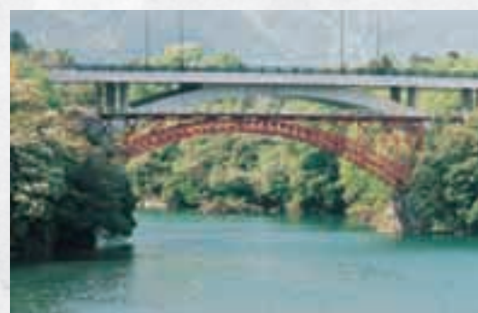
●橋長88mの青柳大橋(奥)。手前に見える旧青柳橋は、青柳大橋完成後、その役目を終えて撤去されました
