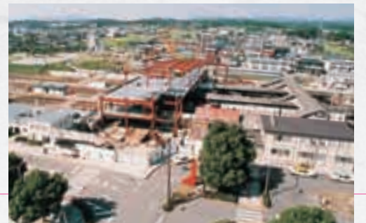
●建設中のJR美濃太田駅新駅舎 (平成9年)
