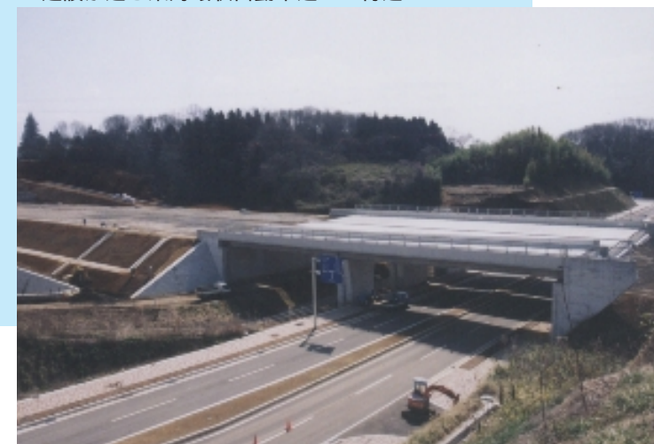
建設が進む東海環状自動車道IC付近
