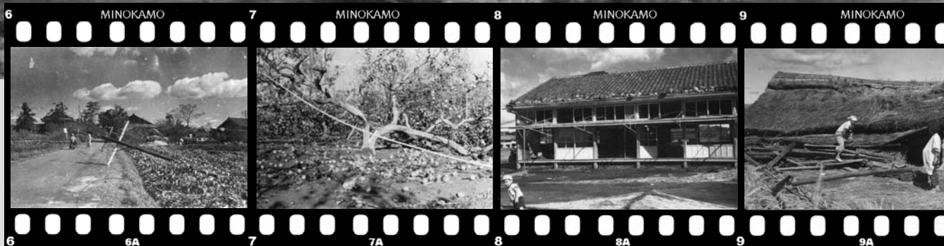
▲古井連絡所前 暴風雨で倒壊した電柱
