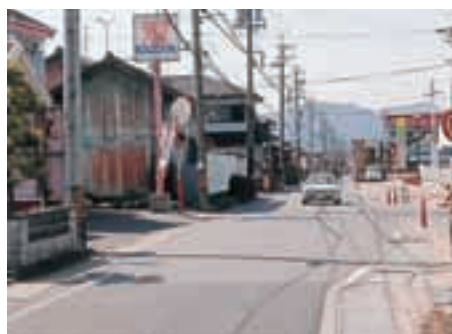
●改良工事が予定されている神明森山線
