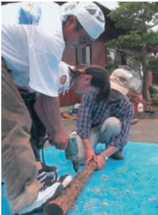
▲原木に電動ドリルで穴を開けている様子
