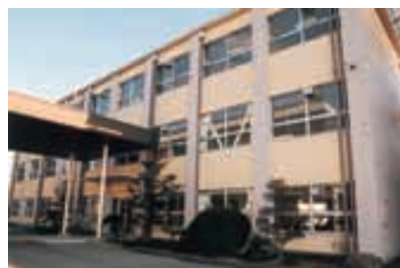
▲耐震補強工事が施された東中学校校舎
