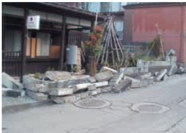
▲地震で倒壊したブロック塀(十日町市内・職員会提供)
