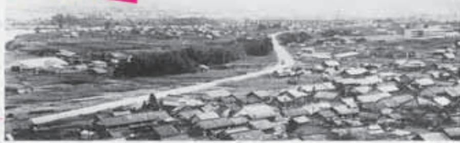
●国道41号(昭和37年・古井地内)
