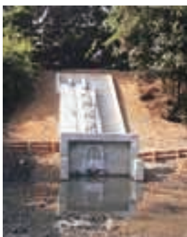
▲新たに整備された排水口
