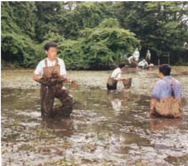
▼池のしゅんせつ工事に伴う、魚などの移設作業の様子
