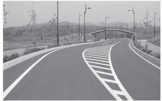
▲一部開通した道路（グリーンロード）
